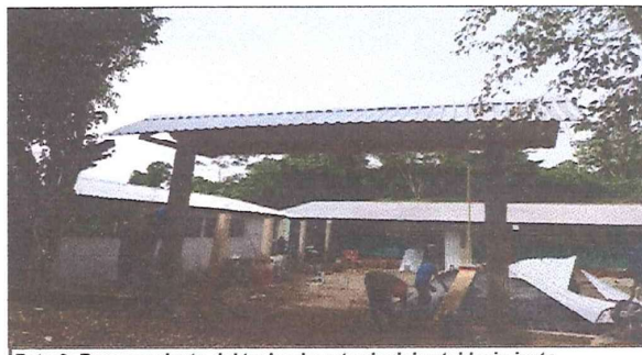
Foto 6: Remozamiento del techo de entrada del establecimiento.
