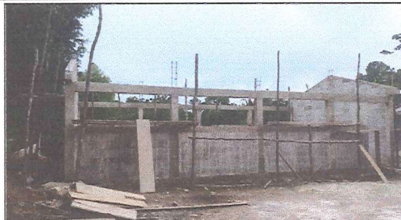
Foto 2: Remozamiento de paredes del aula.
