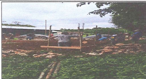
Foto 1: Remozamiento de cimientos del aula
