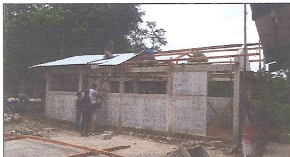
Foto 3: Remozamiento de techo de aula
