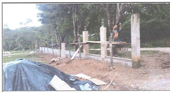
Foto 5: Remozamiento de columnas del perímetro del establecimiento.
